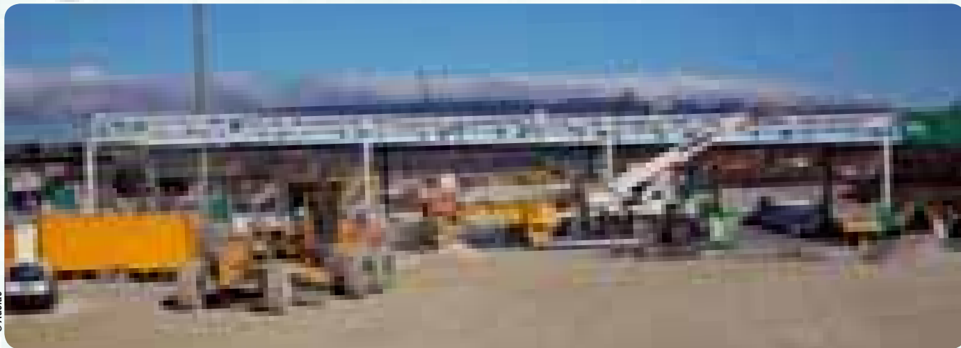
Construction de la barrière de péage de Villy.
