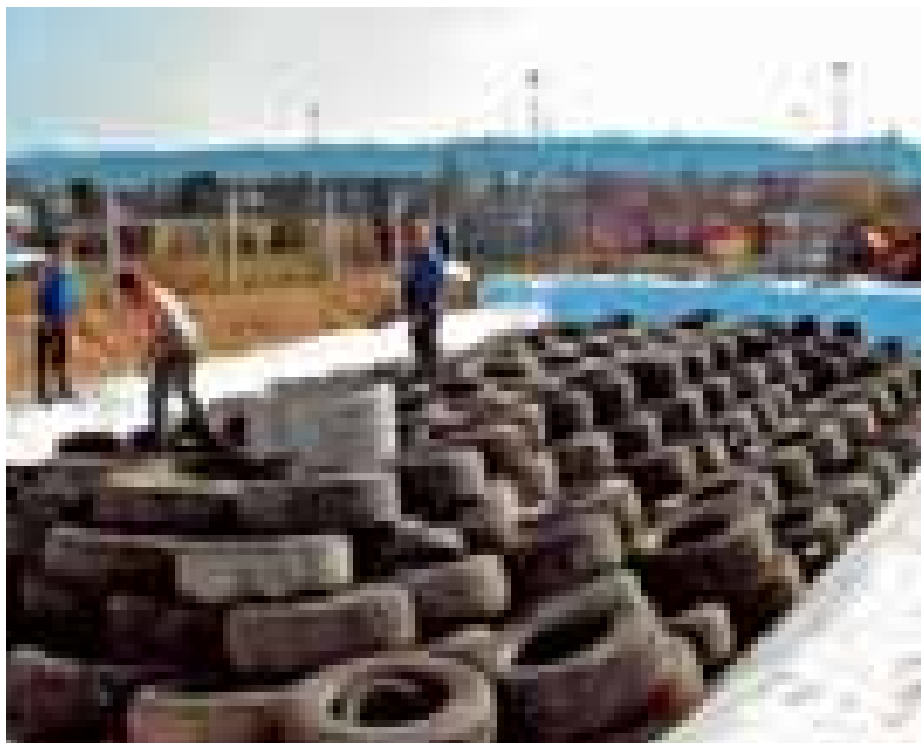
Mise en place de pneus entiers sur un bassin de rétention.
