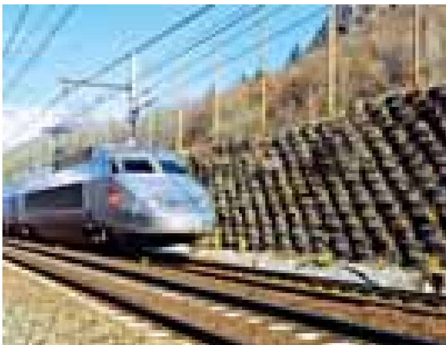
Un mur anti-avalanche construit en bordure des voies ferrées.
