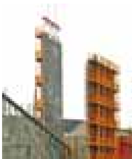
GTB travaille en rotation avec trois équipements de coffrages.
