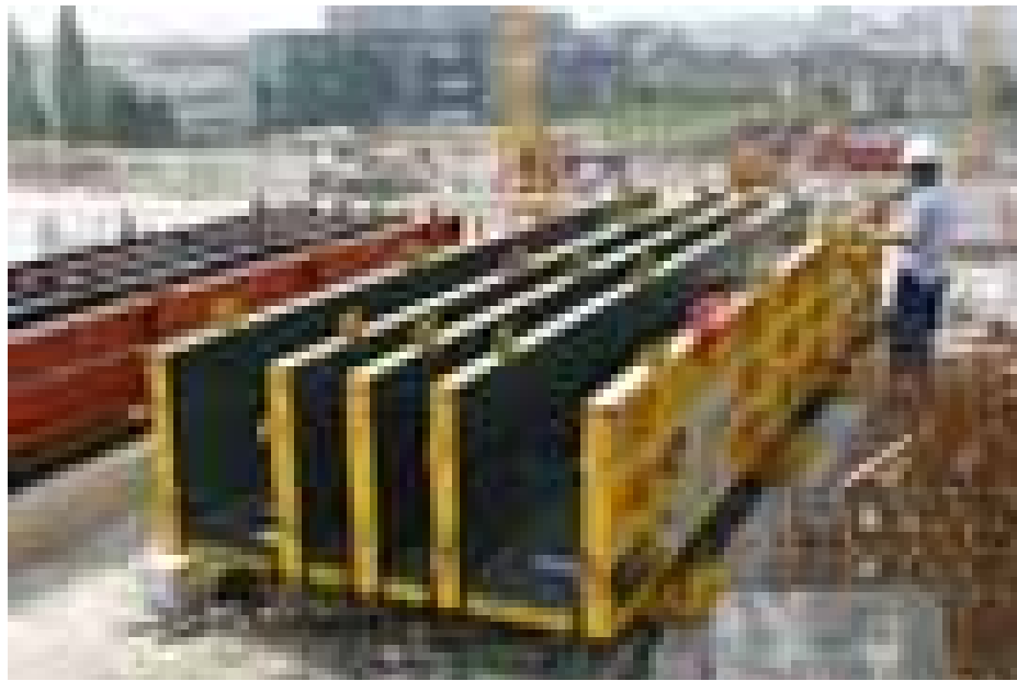
Deux banches sont destinées à la fabrication des poutres.
