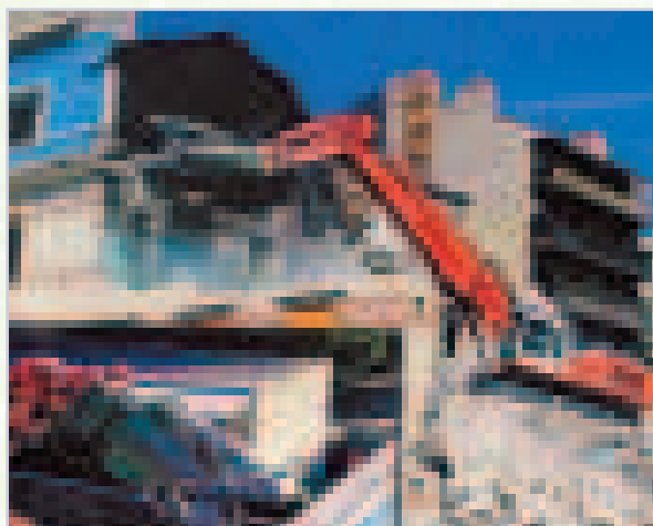
Les pinces de démolition DA 450, DA 550 et DA 580 de Montabert peuvent recevoir maintenant les nouvelles mâchoires RB pour la démolition des structures en béton armé.
